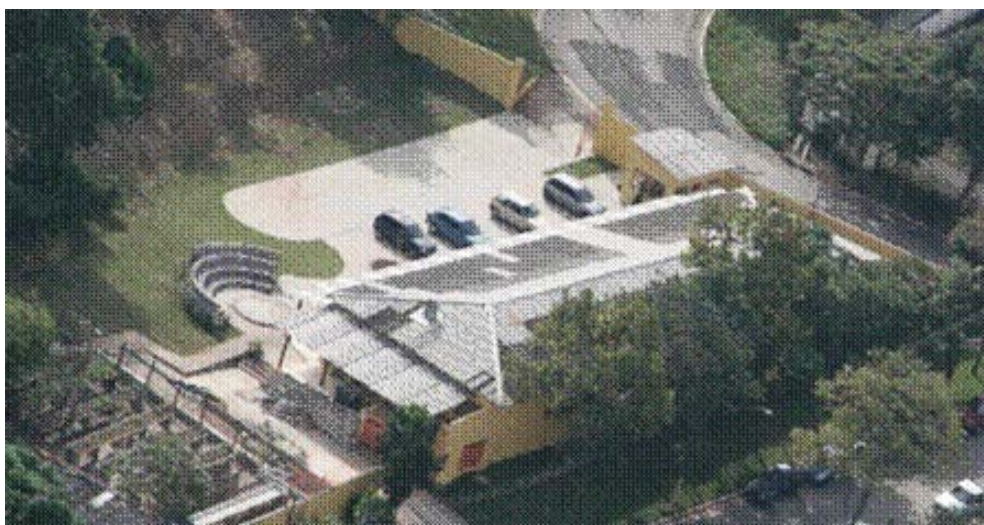
CRSANS, após reforma, 2012
